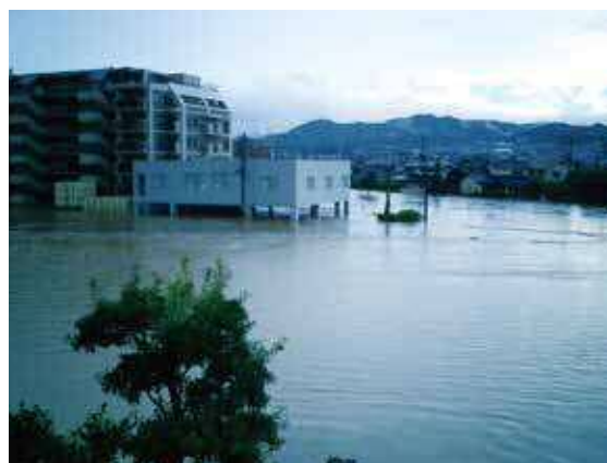
浸水する通古賀の落合橋周辺
